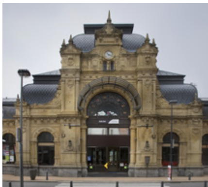
La gare, Arlon
