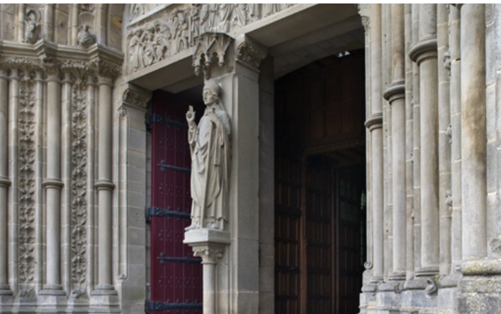
Porte de l'église Saint-Martin, Arlon
