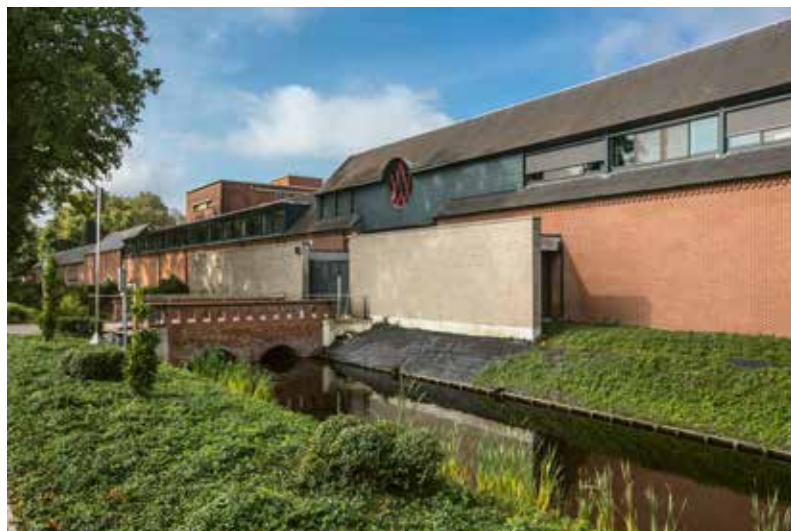
Gauche: La nouvelle salle de la brasserie, en acier inoxydable avec en arrière-plan l'ancienne installation de brassage en cuivre rouge.
